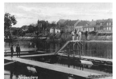
Ehemalige Badeanstalt an der Saale
