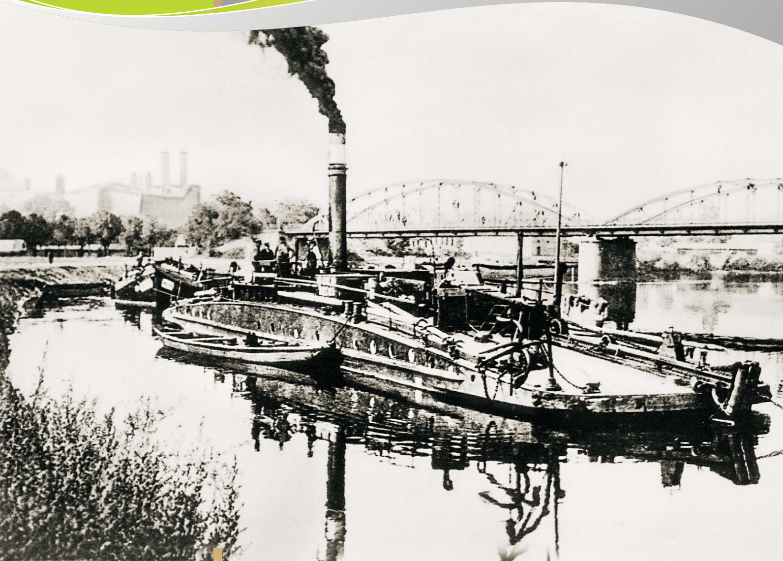
Schleppzug mit Kettendampfer (Leistung: 70 PS) an der Saalebrücke in Nienburg um 1910. Die Kette in der Saale wurde in den Jahren 1883/84 von der Saalemündung bei Barby bis Halle verlegt. Sie hatte eine Länge von 107 km.
